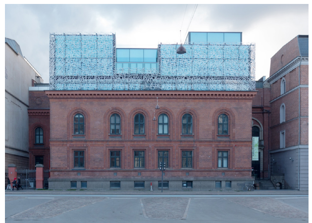
Transformation og tilbygning på bevaringsværdigt byggeri.
