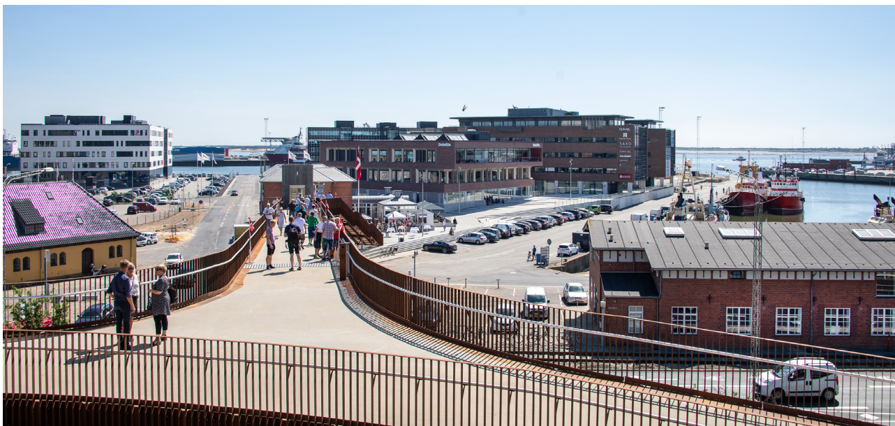
Landgangen som broforbindelse mellem Esbjerg by og havn, indviet 2018.
